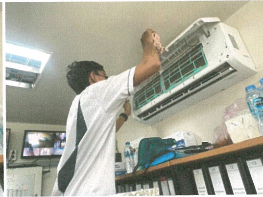
รูปภาพที่ 2.58 การทำความสะอาดเครื่องปรับอากาศ
