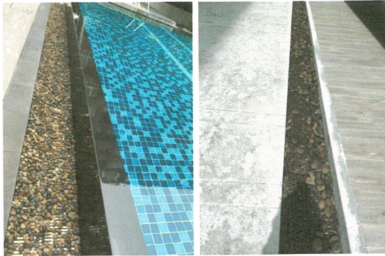
รูปภาพที่ 2.29 รางระบายน้ำล้นรอบสระว่ายน้ำ
