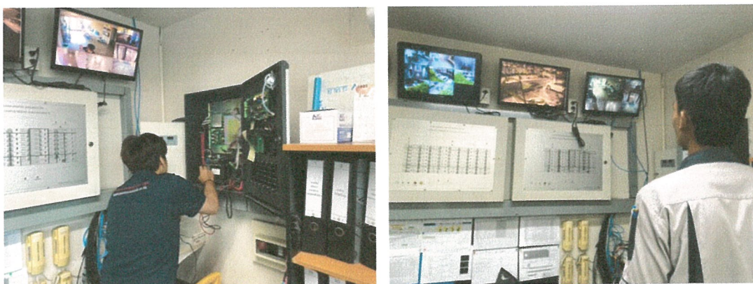
รูปภาพที่ 2.38 การตรวจสอบระบบโทรทัศน์วงจรปิด
